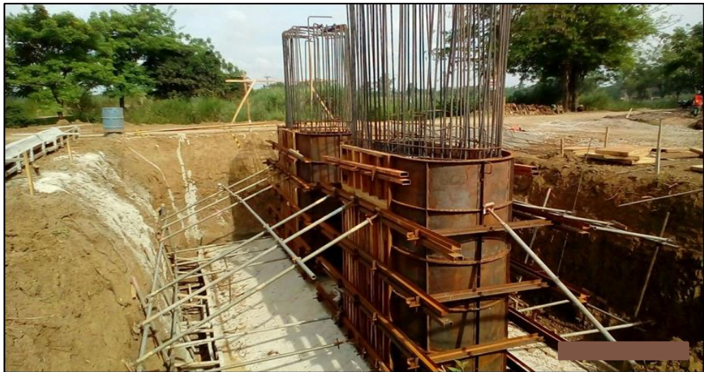
Gambar 3. 2 Pekerjaan Pilar
