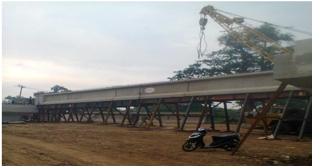
Gambar 3. 4 Girder Sudah Terpasang Di Atas Perancah
